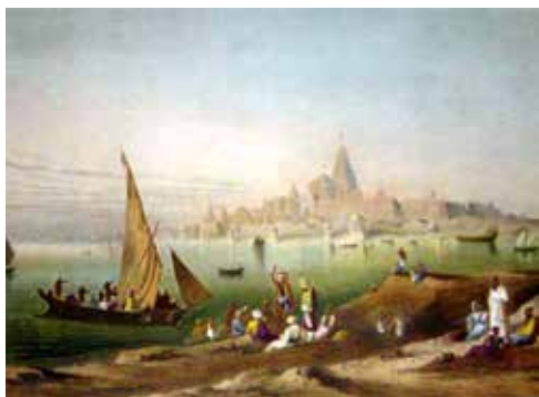
La ville sacrée et les temples de Dvârakan, extrait de l'ouvrage de Grindlay Scenery, Costumes and Architecture chiefly on the Western Side of India , Londres, 1826-30 - Source : Columbia University
